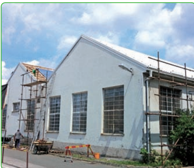
Zagreb, Končar, polikarbonat svjetlarnici sanacija, 2014.
