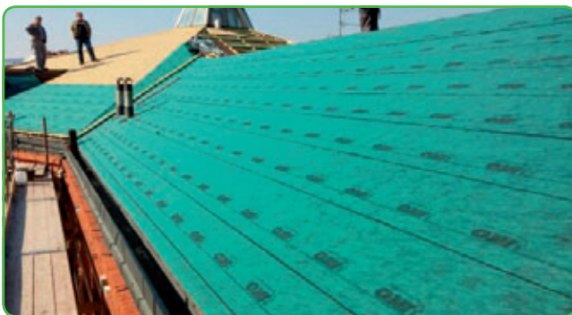
Zagreb, Srednja škola Lucijan Vranjanin, sanacija stare šindre bitumenskom šindrom, 2015 g.
